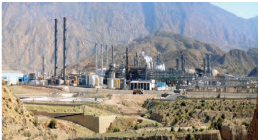
شکل ۱۲-۱۳- تأسیسات گازی پارس جنوبی
