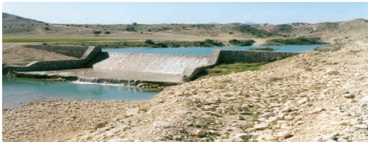
شکل ۱۳-۱۴- احداث استخرهای ذخیره آب
