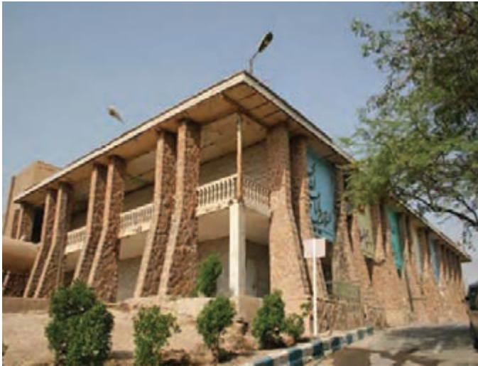
شکل ۳۰-۴. ساختمان گلف در اهواز
