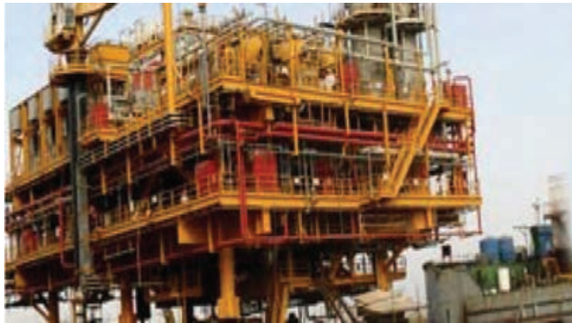
شکل ۳۷-۵- ساخت سازه و سکوهای دریایی در خرمشهر
