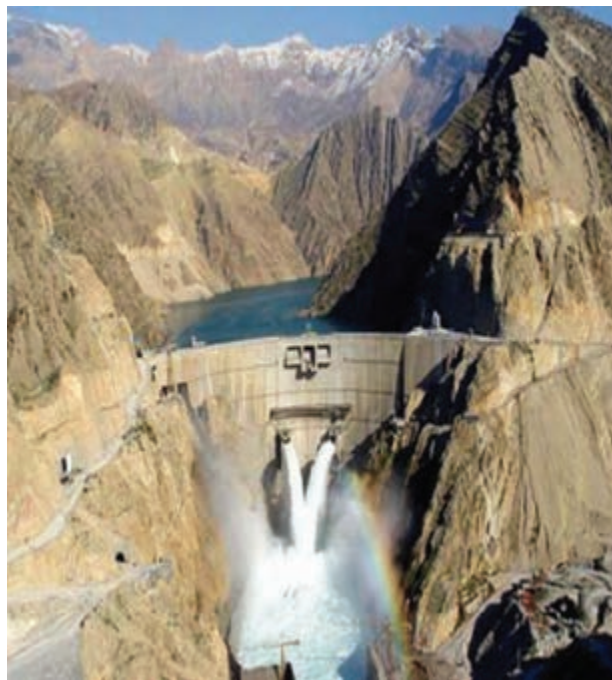
شکل ۴-۶- سد کارون ۳ بلندترین سد بتنی کشور
