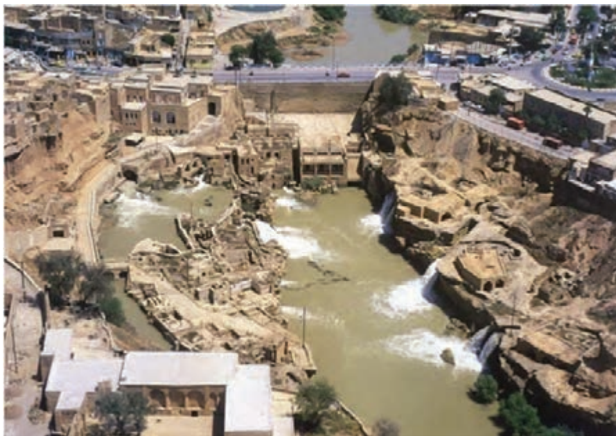
شکل ۱۴-۵- سازه‌های آبی شوستر
