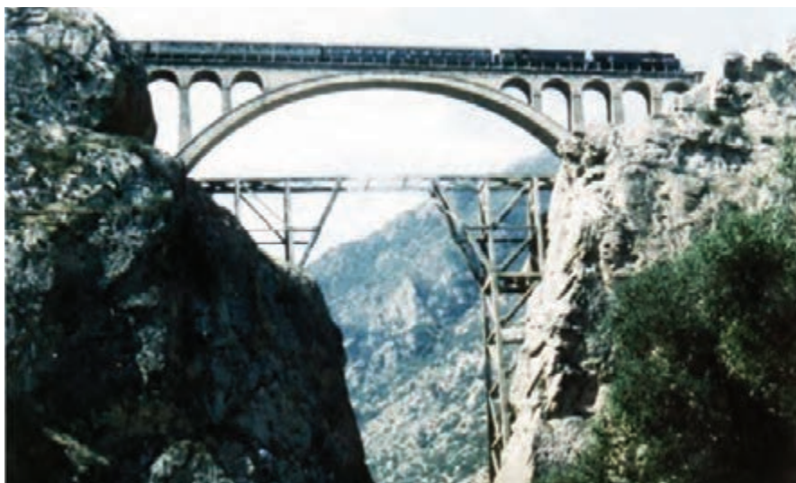
شکل ۲۸-۵- راه آهن شمال - پل ورسک
