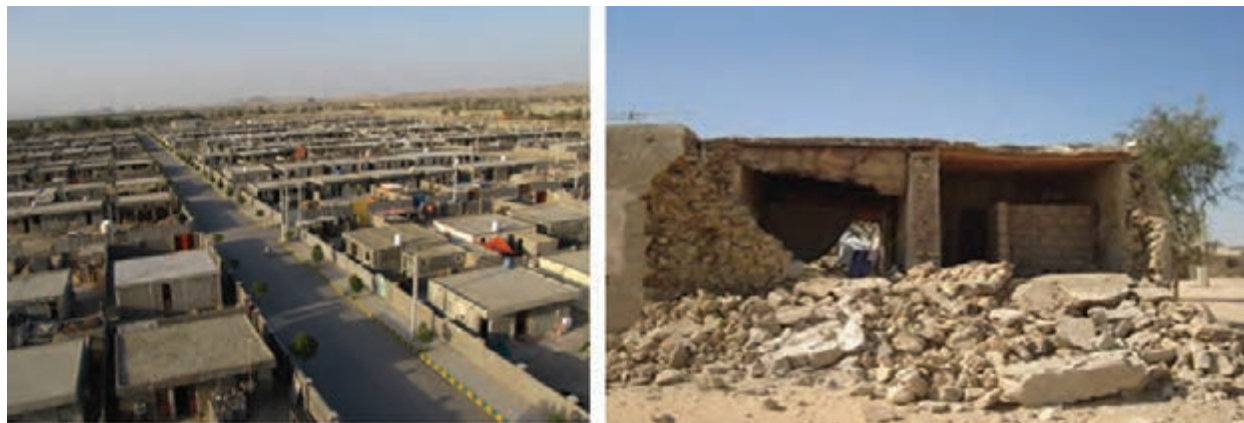
شکل ۶۰-۱- زلزله در شهرستان قشم
