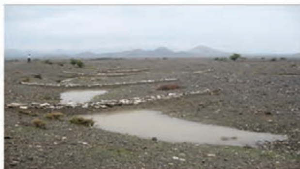
عملیات آبخیزداری احداث بندهای خشک‌چین شکل ۵۹-۱- مجموعه عملیات آبخیزداری
