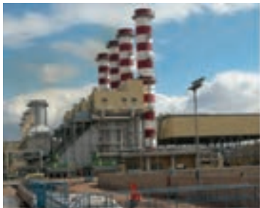
نیروگاه سیکل ترکیبی قم
