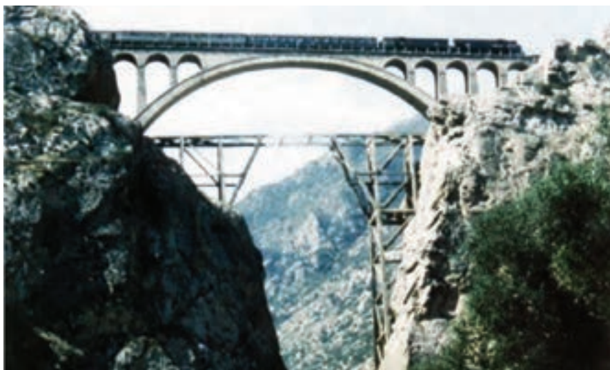
شکل ۲۸-۵- راه آهن شمال - پل ورسک
