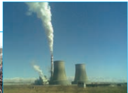
بناب- نیروگاه برق
