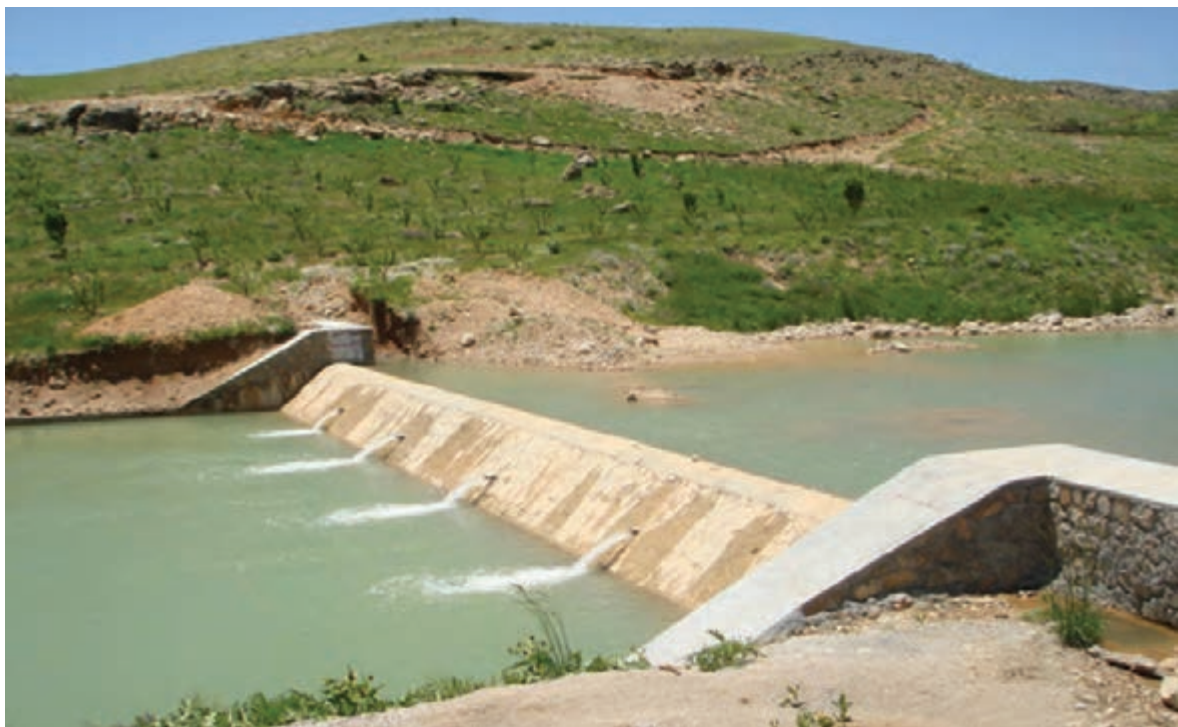
شکل ۲۶-۱- پروژه آبخیزداری بندسنگی ملاتی سرچنار
