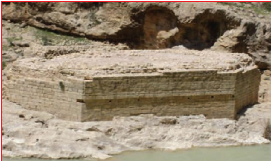
شکل ۳-۴- پایه پل تخت شاه نشین
