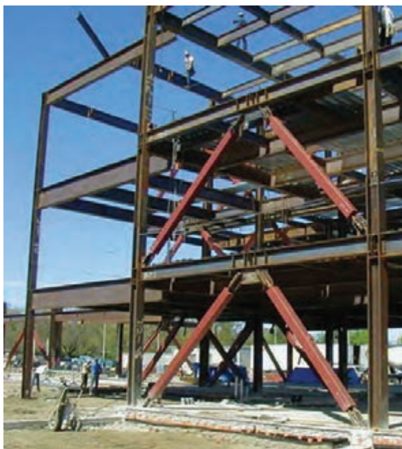
شکل ۵۰-۳- مقاوم سازی ساختمان‌ها در مقابل زمین لرزه
