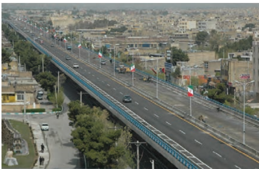
شکل ۳-۷- پل روگذر غیر مسطح امام خمینی (ره)
