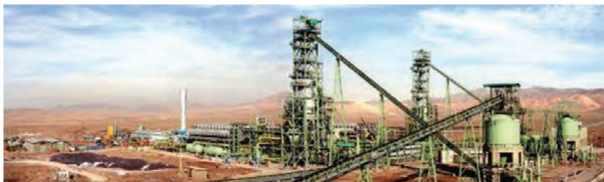
شکل ۳-۶- نمای از کارخانه فولاد خراسان - نیشابور
