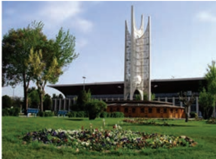
شکل ۴۶-۵- ایستگاه راه آهن مشهد فعال ترین ایستگاه راه آهن کشور بعد از تهران
