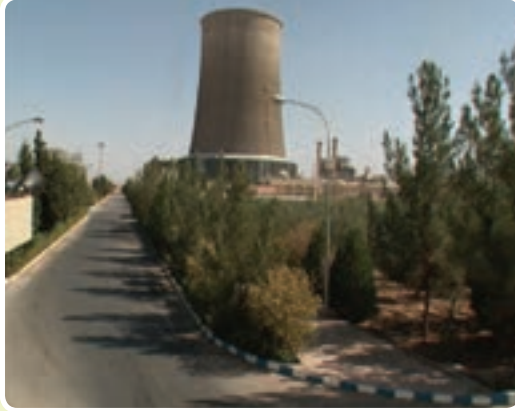
شکل ۱۰-۶- نیروگاه سیکل ترکیبی
