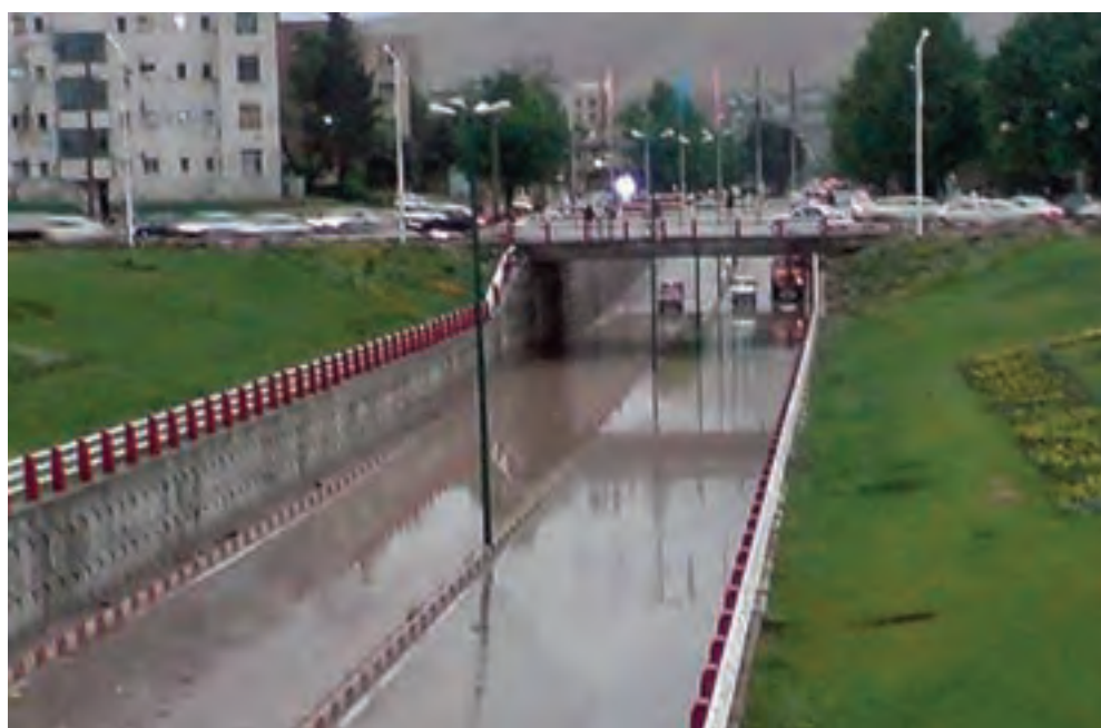
شکل ۱۰-۱۴- یکی از زیرگذرهای شهر خرم‌آباد
