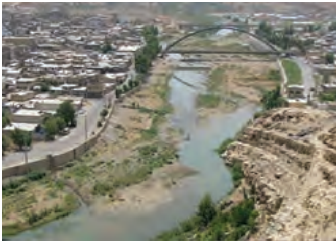
شکل ۷-۵ - خرم‌رود در فصل کم آبی
